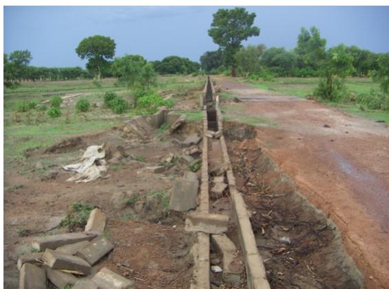
*Photo 1 : Rupture de la digue du barrage de Lilougou*
